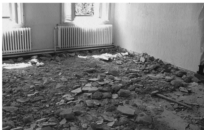
Bourání staré podlahy
