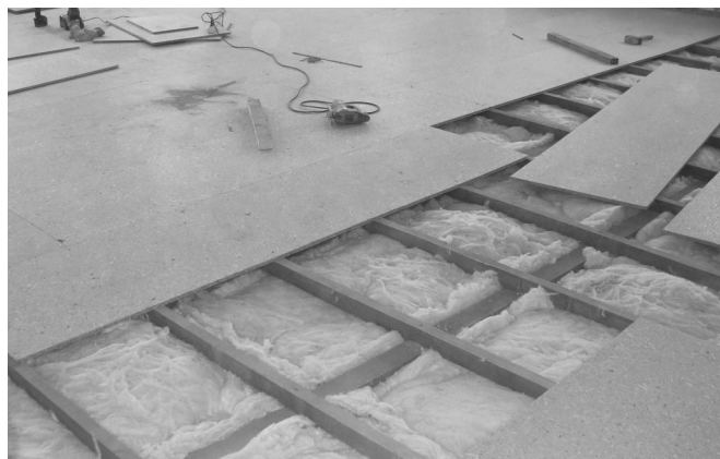
Záklop nové podlahy
