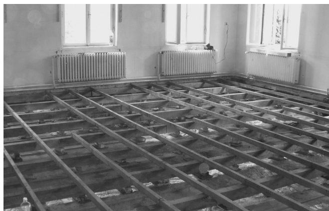
Nosný rošt nové podlahy
