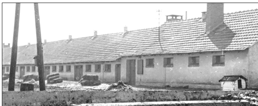
Porodna pro prasnice č.II, postavená v roce 1958-59
