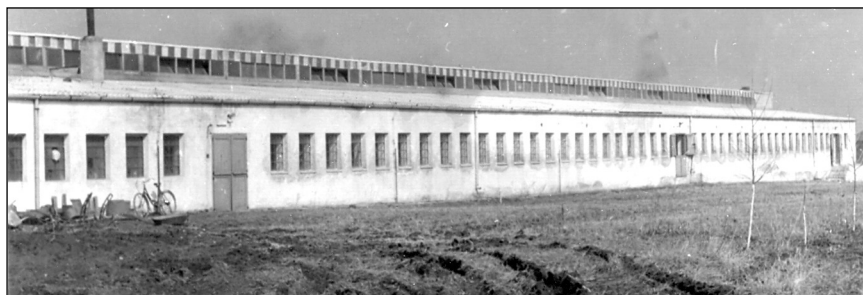
Čtyřřadý kravín s aut.dojením, postaven v roce 1962-63
